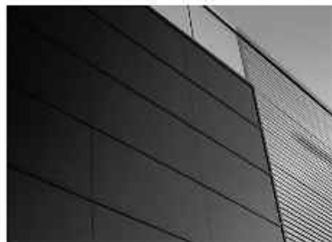
Produktionshalle der VonArtenne Anlagentechnik GmbH in Dresden/Weißig
